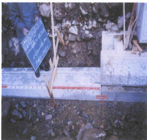
基礎盤の固定
