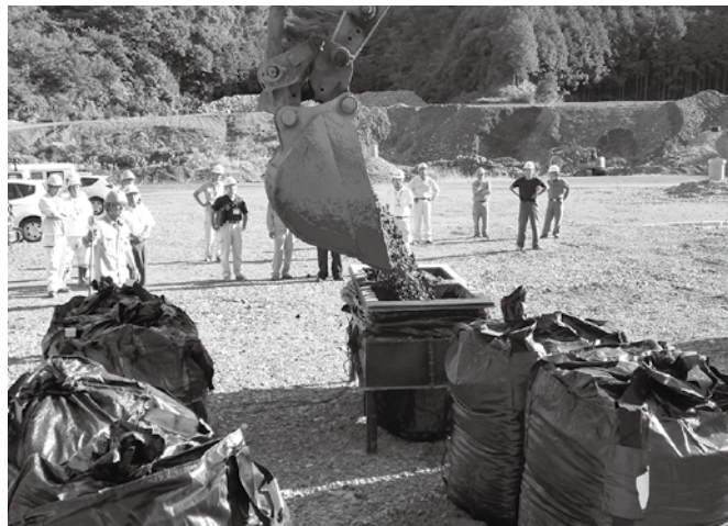
▲(写真2)大型土のう製作機
