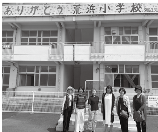
▲震災遺構 仙台市立荒浜小学校
