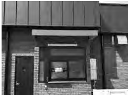
店舗テント設置
