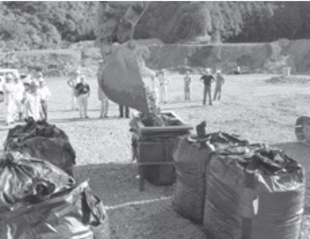
大型土のう製造している様子
