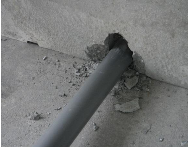
ノックアウトでVP75mmに対応できる
