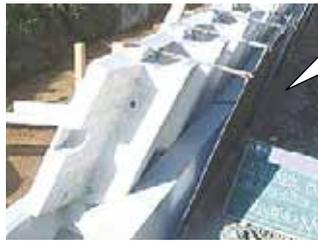
抜き型枠（鉄板）
