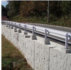
L型擁壁 (天端部分を外した例)
