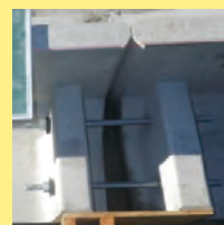
連結筋設置完了
