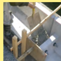
コンクリート打設状況
