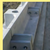
間詰めコンクリート完了
