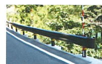
補修後の全景
