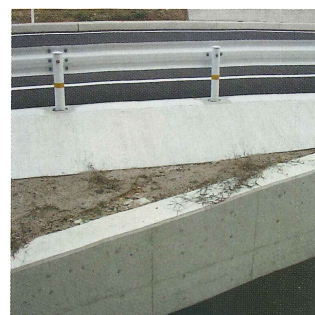
盛土（BOX上の盛土）
