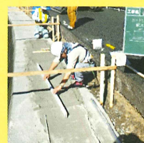
敷きモルタル
