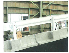
縦断16%の設置確認
