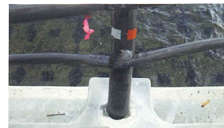
横断方から見た状況
