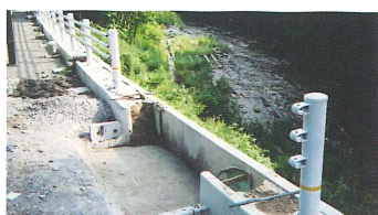
⑤ 製品を撤去した状況
