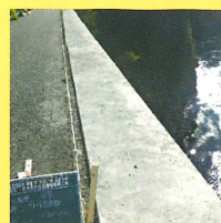
均しコンクリート
