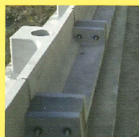
間詰めコンクリート完了
