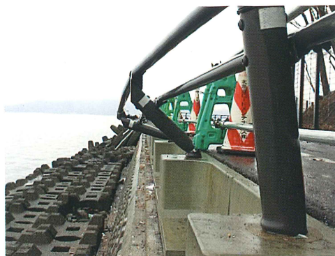
横方向から見た状況
