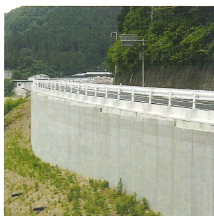
軽量盛土（発泡モルタル）
