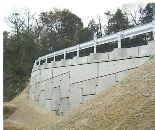
補強土壁（スーパーターmal）
