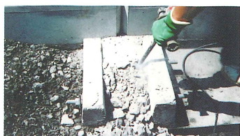
④ 間詰めコンクリート除去
