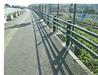
補修した後の全景
