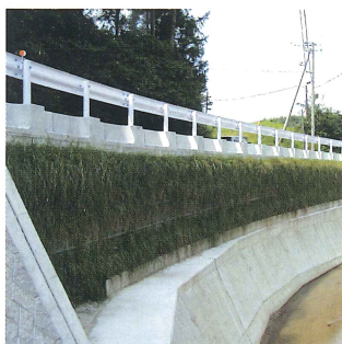
ジオテキスタイル補強土壁
