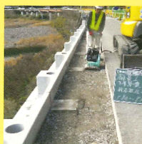
埋戻し、路盤工施工
