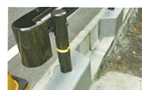
補修した2本の近景
