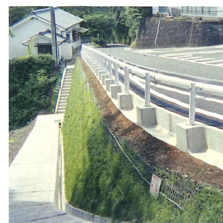
ジオテキスタイル補強土壁
