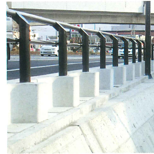
大型ブロック積擁壁
