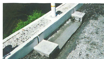
③ 底版上の土を取り除いた状況
