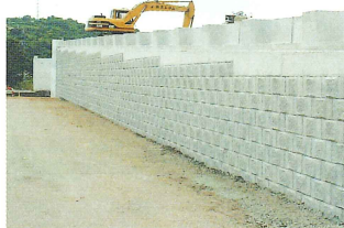
補強土壁（ジオグリット）
