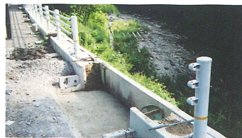
⑤製品を撤去した状況
