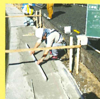
敷きモルタル
