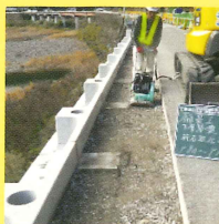
埋戻し、路盤工施工
