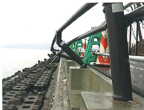
横方向から見た状況
