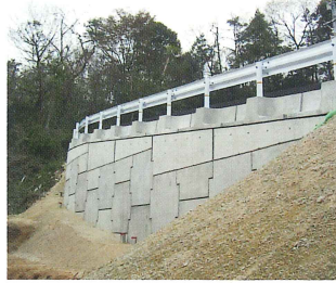
補強土壁（スーパーターmal）
