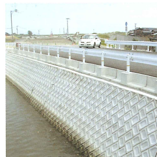
間知ブロック積擁壁
