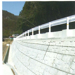
大型ブロック積擁壁
