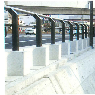
大型ブロック積擁壁
