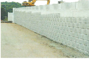
補強土壁（ジオグリッド）
