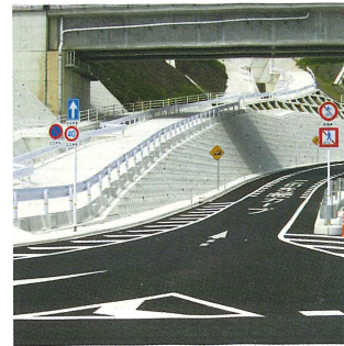
間知ブロック積擁壁
