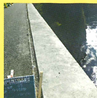
均しコンクリート
