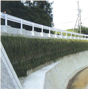
ジオテキスタイル補強土壁
