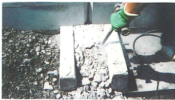
④間詰めコンクリート除去
