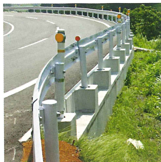
L型擁壁（天幅前面に合わせた例）
