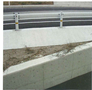
盛土（BOX上の盛土）
