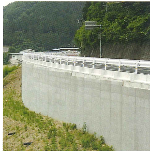
軽量盛土（発泡モルタル）
