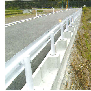
既設石積擁壁
