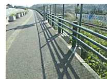
補修した後の全景
