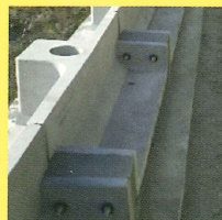
間詰めコンクリート完了
