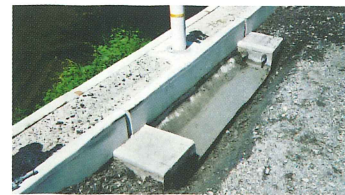
③底版上の土を取り除いた状況
