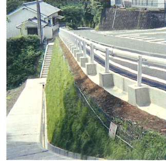
ジオテキスタイル補強土壁
