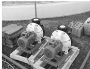
③ 取水ポンプ 沿岸部に掘った井戸から地下水を汲み上げる設備
