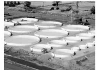
② PP(ポリプロピレン)水槽 アオノリの生育状況に合わせてサイズの異なる水槽に移動させるため、直径1m、2m、5m、10mの水槽各5基
